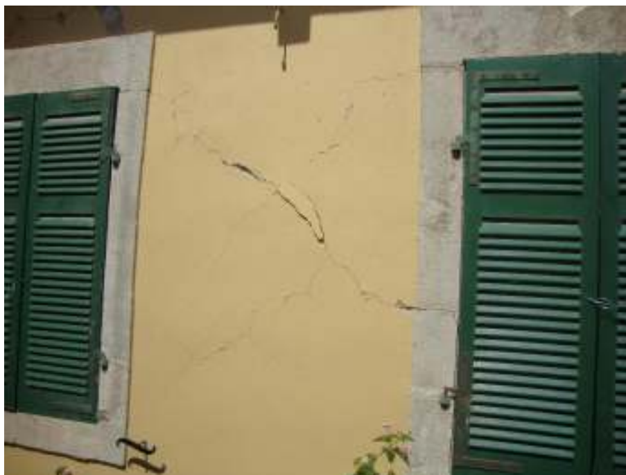
Φωτογραφία 3: Πεσσό της νότιας όψη στη στάθμη ισογείου.
