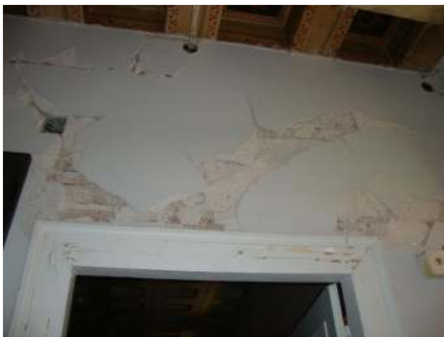
Φωτογραφία 8: Υπέρθυρο εσωτερικού ξυλόπηκτου τοίχου.
