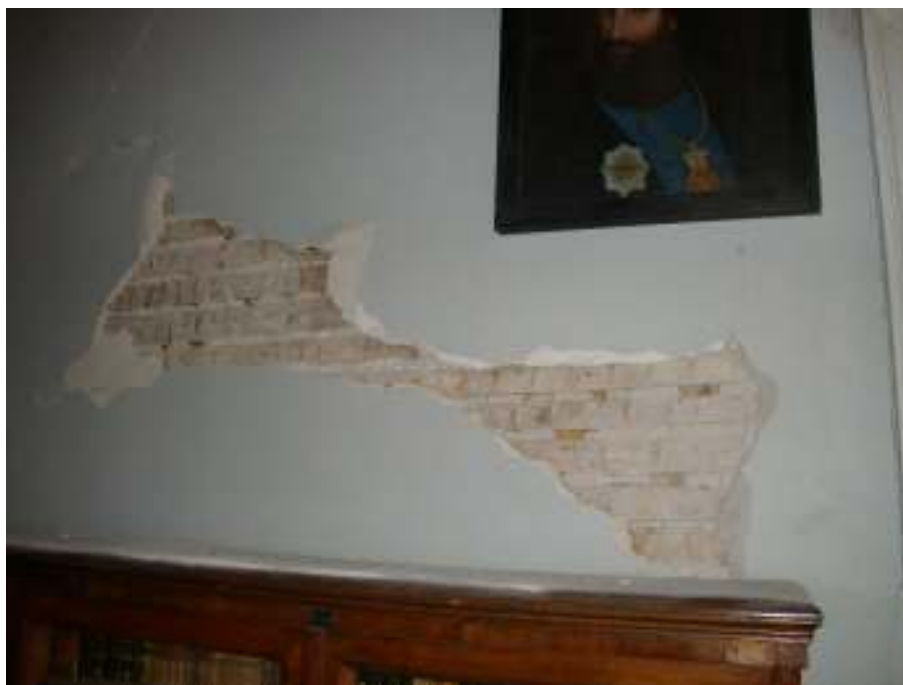
Φωτογραφία 7: Εσωτερικού ξυλόπηκτος τοίχος.
