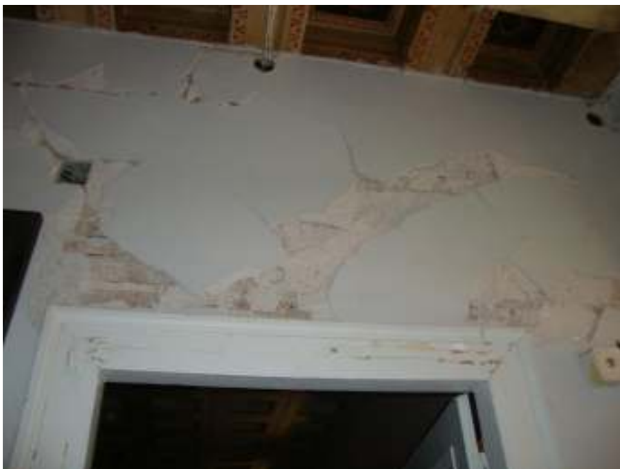
Φωτογραφία 12: Ρωγμές σε υπέρθυρο εσωτερικού ξυλόπηκτου τοίχου.
